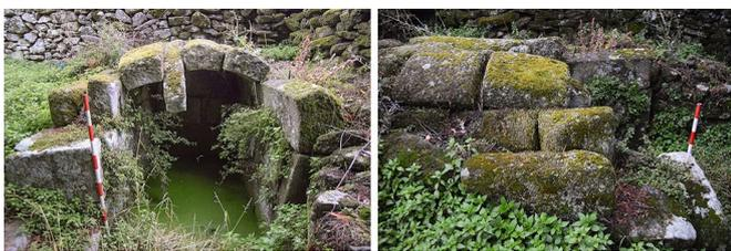
Figura 5. Fuente abovedada con depósito de Belver. Vistas frontales y laterales de la estructura en las que se puede observar el derrumbe parcial de su bóveda en la zona delantera y las inestabilidades estructurales en la parte que aún se mantiene cubriendo el depósito.
