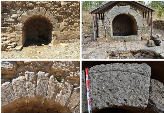
Figura 8. A la izquierda vista general de la estructura de El Burgo, en la que puede apreciarse la línea incisa que recorre su arco, cuyo detalle está bajo esta imagen. A la derecha vista general de la fuente abovedada con depósito de San Pedro de la Viña, y bajo ella el detalle de la línea incisa de su arco.
