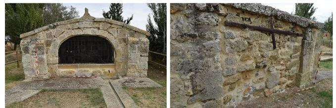
Figura 13. Fuente abovedada con depósito de Guaza de Campos. A la izquierda una vista frontal en la que pueden observarse múltiples modificaciones arquitectónicas y ornamentales. A la derecha detalle de una restauración antigua, que evidencia los problemas estructurales de la construcción.
