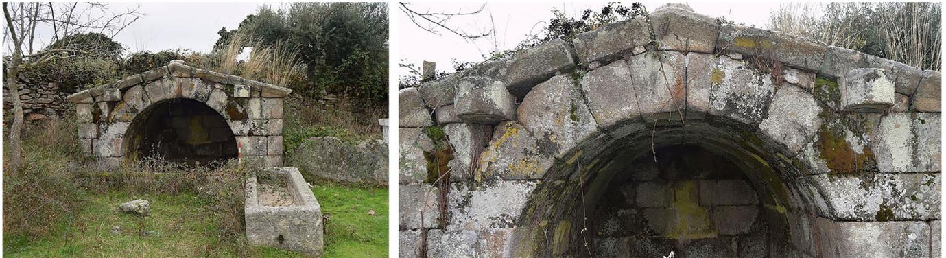
Figura 7. Fonte da Pereira de Vilar de Amargo (Guarda). A la izquierda una vista frontal. A la derecha detalle de los goznes y la cubierta, en la que se puede apreciar la inestabilidad estructural de esta última.
