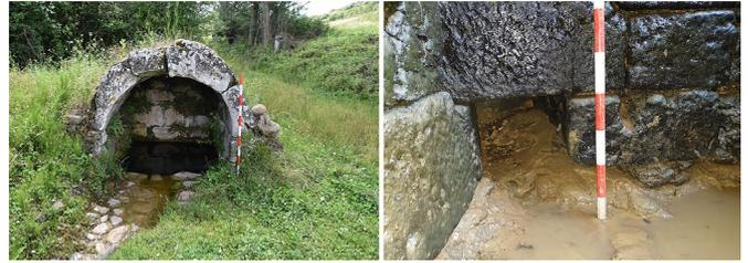
Figura 12. Fuente abovedada con depósito de Valdealcón. A la izquierda una vista frontal. A la derecha puede observarse el detalle exterior de su entrada de agua.
