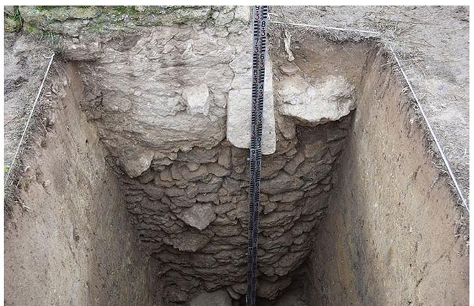
Figura 11. Fuente abovedada con depósito de San Pedro de Villafáfila. A la izquierda una vista frontal. A la derecha detalle del sondeo practicado en ella, en él puede observarse la presencia de una pared curvada que enmascara el depósito rectangular localizado bajo la bóveda.
