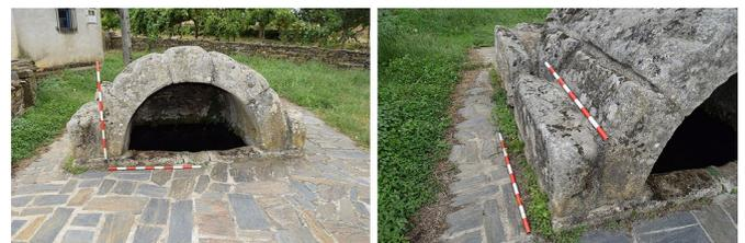
Figura 9. Ejemplo del grupo tipológico 2.2. Fuente abovedada con depósito de la Cantería (Matellanes, Zamora). A la izquierda vista general de la construcción. A la derecha detalle de los contrarrestos de uno de sus laterales.
