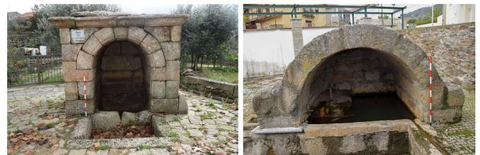
Figura 6. Ejemplos del grupo tipológico 2.1. A la izquierda la estructura de Valverde (Vila Real). A la derecha la fuente de Lodões (Braganza), en la que se puede observar la morfología de sus bloques basales pese al desmantelamiento de la cubierta.
