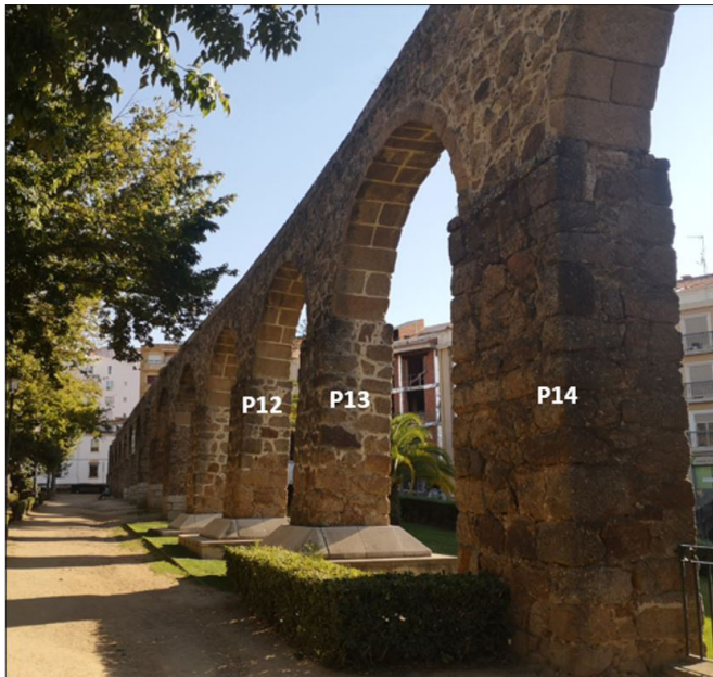
Figura 9. Pilares tipo 1 (desde P1 a P18) en el tramo 1 del acueducto. Fuente: elaboración propia (2021).
