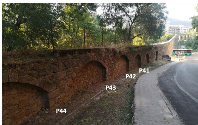
Figura 15. Pilares tipo 8 embebidos en tramo de muro. Fuente: elaboración propia (2021).
