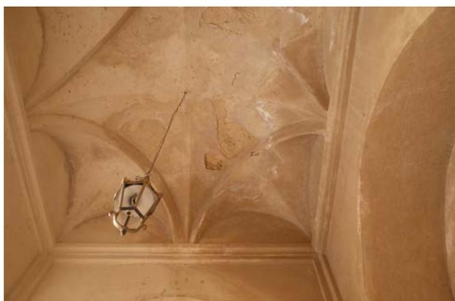
Figura 19. Bāb al-Sab'. Bóveda de arista a 45° sobre trompas cubriendo uno de los módulos intermedios. Fotografía del autor.
