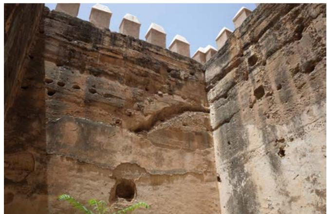
Figura 33. Bāb al-Sab'. Bastión oriental. Huellas de la escalera que llegaba al tercer nivel. Fotografía del autor.
