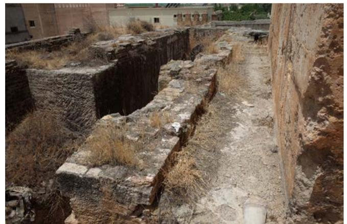
Figura 9. Noria. Coronación de la caja con estructura de pilares sobre el muro septentrional. A la izquierda, reducción del espesor del muro meridional como parte de las transformaciones industriales del siglo XIX. Fotografía del autor.
