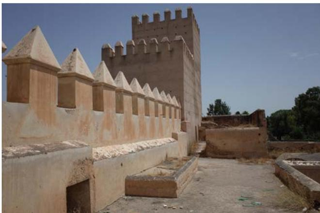
Figura 32. Bāb al-Sab'. Azotea superior. En primer plano, remate sellado de la buhedera y parapeto del patio. Al fondo, bastión oriental. Fotografía del autor.
