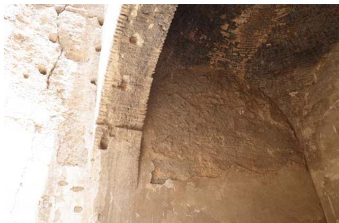
Figura 28. Bāb al-Sab'. Bastión occidental. Detalle de arco diafragmático que divide el segundo nivel en dos espacios distintos. A la derecha cúpula vaída sobre el módulo lateral. Fotografía del autor.
