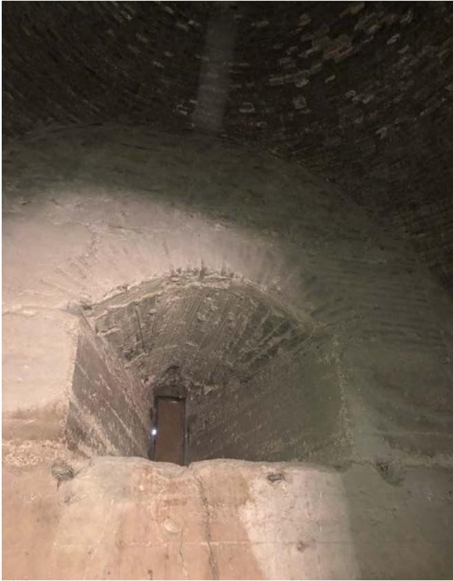
Figura 24. Bāb al-Sab'. Bastión occidental. Detalle de aspillera. Fotografía del autor.
