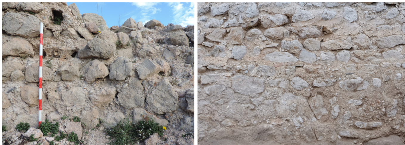
Figura 8. Sistema constructivo mediante mampostería concertada (M2). Imagen de autoría propia.
