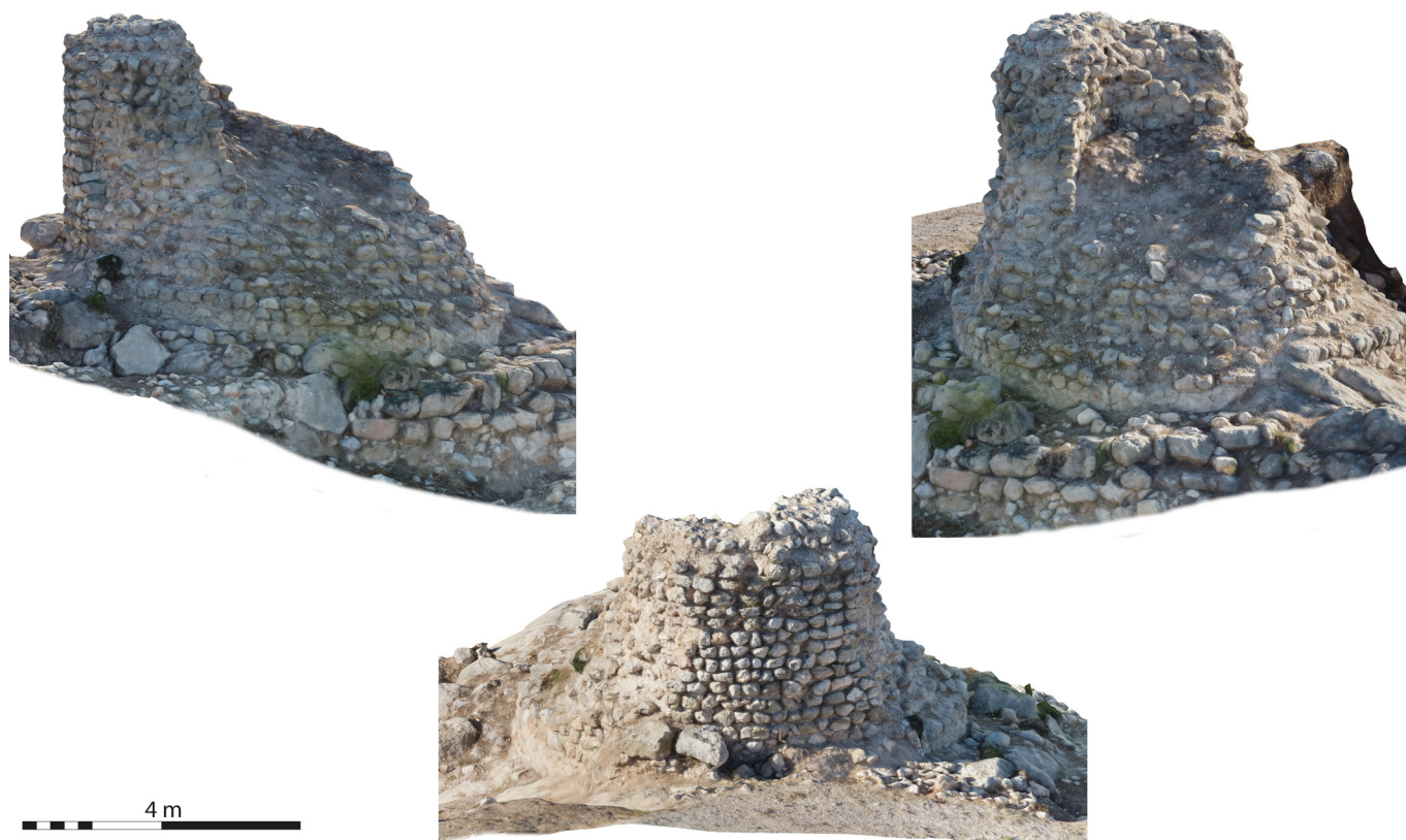
Figura 24. Modelo fotogramétrico de la Torre B1 de la albacara. Imagen de autoría propia y de Nacho Segura, El Tossal Topografía.
