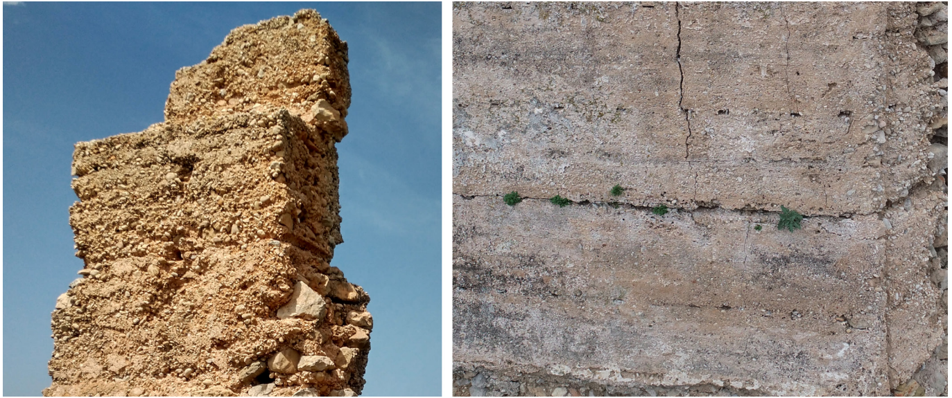
Figura 11. Sistema constructivo mediante tapial de hormigón de cal (T2). Imagen de autoría propia.
