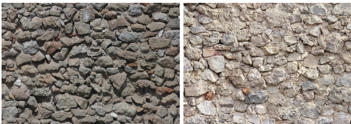
Figura 9. Sistema constructivo mediante mampostería ordinaria (M3). Imagen de autoría propia.
