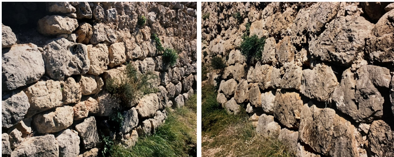
Figura 5. Sistema constructivo mediante sillarejo trabado con tierra (SJ1). Imagen de autoría propia.
