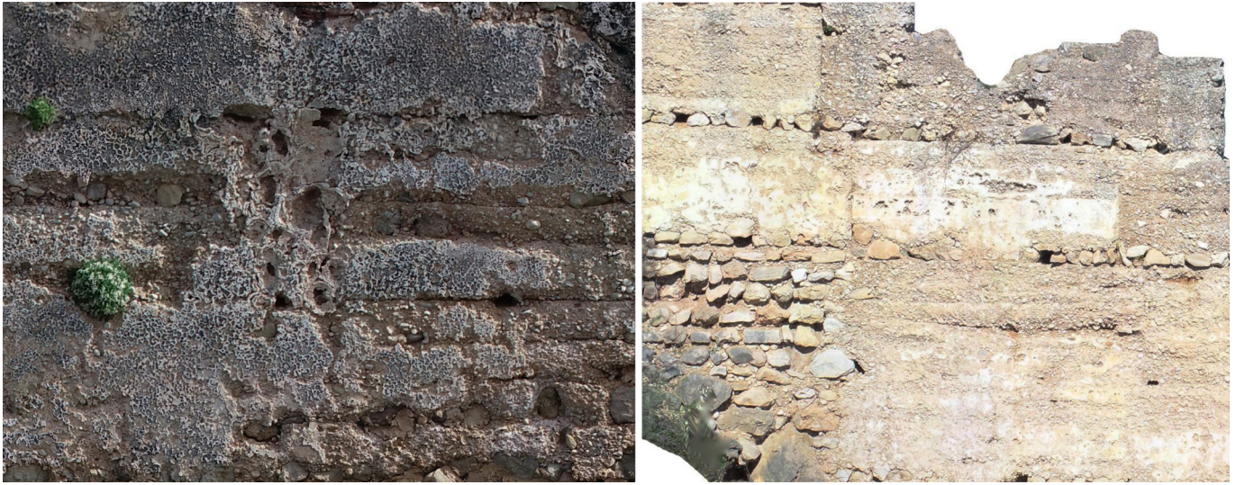
Figura 12. Sistema constructivo mediante tapial calicostrado (T3). Imagen de autoría propia.
