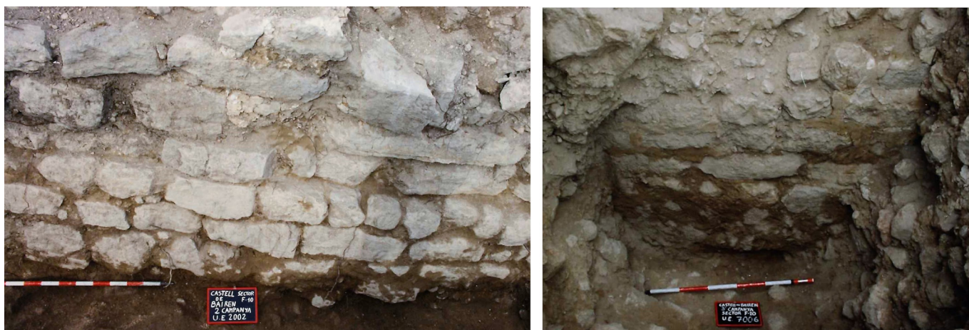
Figura 6. Sistema constructivo mediante sillarejo trabado con mortero (SJ2). Imagen de autoría propia.
