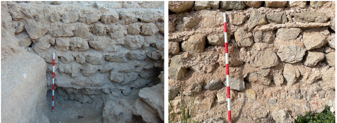
Figura 7. Sistema constructivo mediante mampostería desbastada dispuesta en hiladas (M1). Imagen de autoría propia.
