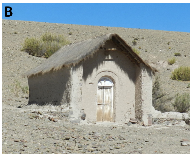
Figura 14. Oratorios en la Puna de Jujuy. A: Oratorio abandonado en el paraje Puesto de la Peña. B: Oratorio en uso en la localidad de San Juan de Oros. Nótese en ambos casos el uso de arcos para entrada y nichos, como también el ingreso y el altar-retablo ubicados en el segmento más corto de la construcción. Fotografías de los autores.
