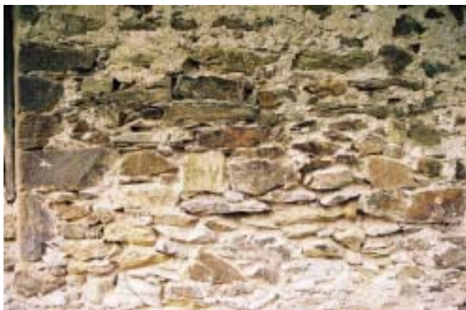
Fig. 6. San Vicente de Vil.latexil. Siglo XIII. Paramento de mampostería enripiada de pizarra que apenas forma hiladas rústicas, colocándose las lajas de pizarra sin apenas retoques, aprovechando su propio corte. Los huecos se rellenan con esquirlas de pizarra recubiertas de mortero por todos los lados. En el entronque de la nave con el presbiterio se utilizan lajas de mayor envergadura, apenas retocadas a martillo para facilitar la superposición de las hiladas
