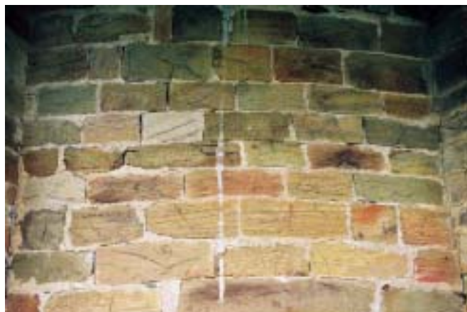
Fig. 8. San Miguel de Bárzana. Siglo XII. Presenta distintas técnicas constructivas que podrían datar de periodos cronológicos distintos. La cabecera está realizada en sillares de arenisca bien escuadrados, de pequeñas dimensiones, en los que apenas se aprecian las maestras que caracterizan el trabajo de sillería y con un acabado de las superficies realizado con azuela
