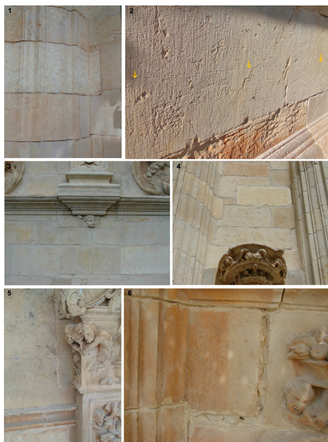
Figura 7. Características constructivas del siglo XVI. 1. Adosamiento de la fachada (izq.) en la iglesia (der.). 2. Línea de replanteo cincelada. 3. Las basas de las pilastras del primer piso están integradas en el zócalo. Se recortaron los sillares de la moldura y se encastraron cuando el zócalo estaba concluido. 4. En las hornacinas, se armaron las jambas y luego se rellenó el interior. 5. Uso de engatillados para ajustar elementos ornamentales como los capiteles de las pilastras. 6. Lascas de piedra caliza utilizadas como cuñas en las juntas más anchas.
