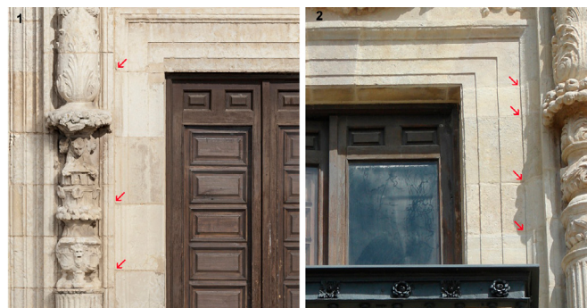
Figura 13.1. Pérdida de isodomía entre jambas y pilastras-columnas abalaustradas en los balcones abiertos en el siglo XVIII sobre la fachada renacentista. 2. En los balcones de la fachada del siglo XVIII la isodomía es completa entre jambas, pilastras y columnas abalaustradas.
