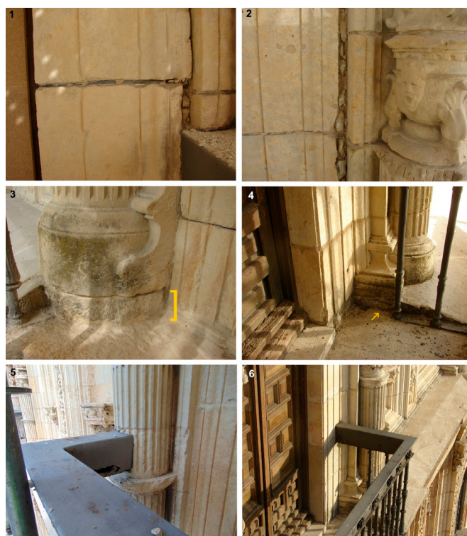
Figura 14.1. Lascas de caliza y esquisto o pizarra en los balcones de la fachada del s. XVI. 2. Lascas gruesas de caliza para rellenar juntas anchas en los balcones de la fachada del s. XVI. 3. Pequeño tambor tallado in situ , en los balcones de la fachada del s. XVI, en el cimacio de la cornisa. 4. Las huellas de los balcones de la fachada del s. XVIII, mediante el desbaste del cimacio de la cornisa, no afecta a jambas ni a basas de las columnas. 5. En la fachada del siglo XVI la anchura de los balcones varía, por lo que se llegó a encastrar el pasamanos en las columnas abalaustradas. 6. En la fachada del siglo XVIII los balcones tienen las mismas dimensiones y el pasamanos se encastró en las jambas.
