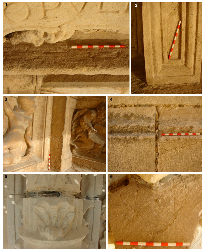
Figura 17. Características constructivas del siglo XVIII. 1. Talla a gradina en superficies horizontales no visibles. Escala de 10 cm. 2 y 3. Talla a cincel en superficies vistas. Escala de 10 cm. 4. Talla a gradina y uso de pequeñas piedras de cuarcita y esquisto o pizarra en la unión entre sillares. Escala de 10 cm. 5. Cuñas gruesas en las juntas más anchas. 6. En capiteles y penas es recurrente el uso de líneas de replanteo que de manera radial marcan los ejes de simetría. Escala de 10 cm.
