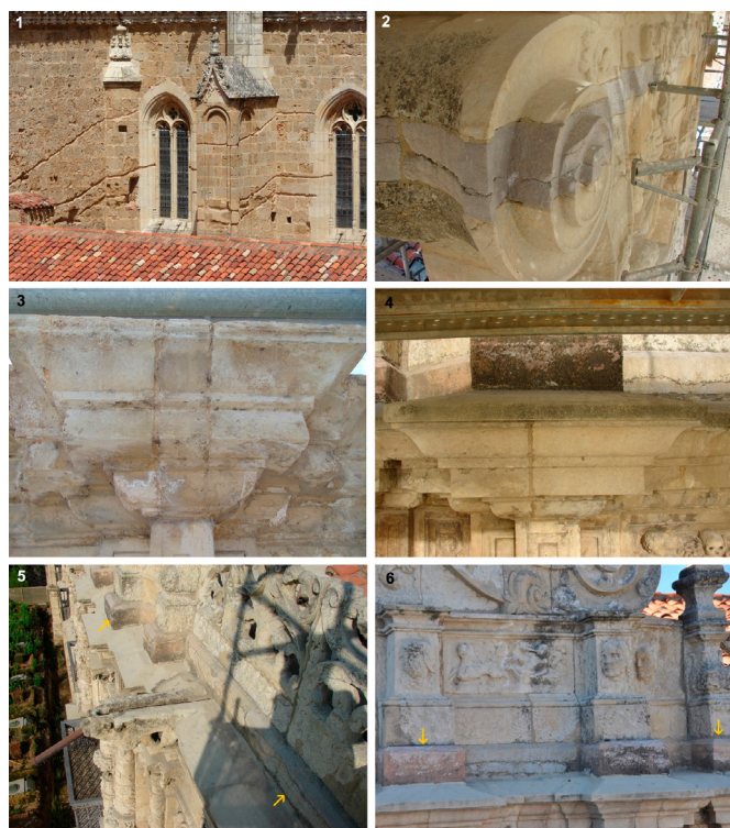
Figura 10.1. Rozas en la fachada de la iglesia que indican las diferentes alturas que ha tenido la cubierta del claustro. 2. Piedra lutila en las volutas de los aletones de la peineta (s. XVIII). 3. Albardilla del s. XVI que permitía la evacuación del agua del tejado. En el s. XVIII la canalización fue tapada y disimulada en el frontal con una piedra moldurada. 4. Albardilla del s. XVIII, meramente decorativa y sin el sistema de evacuación del agua del tejado. 5. En el siglo XIX se elevó la posición de la crestería mediante un pretil o antepecho. 6. En la peineta, donde no hay crestería, se picó una roza en la que se encastró un filete para dar continuidad lineal al conjunto.
