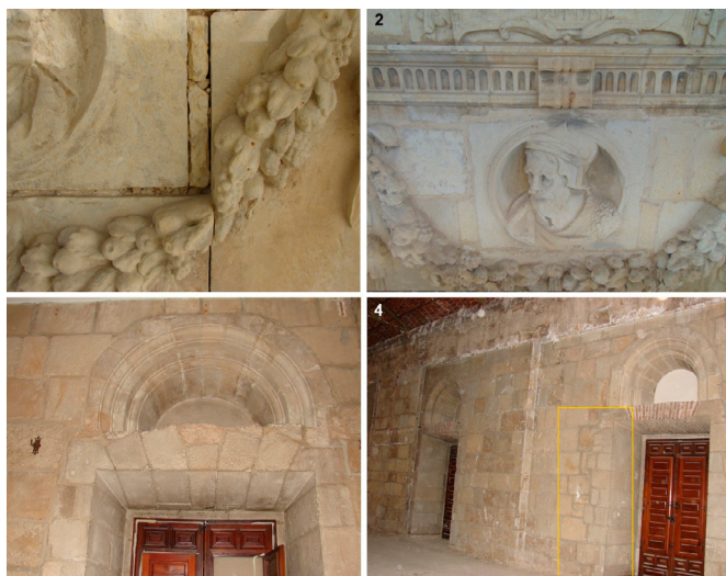
Figura 15. Detalles de los balcones abiertos en el siglo XVIII sobre la fachada del siglo XVI. 1. Se integraron elementos ornamentales existentes previamente que en algunos casos fueron cortados para ajustarlos al nuevo espacio, y las juntas se rellenaron con recortes de piedra. 2. Pequeñas piezas de sillería encajadas en torno a medallones y guirnaldas. 3. En el interior del edificio se conserva parte de los vanos originales en arco de medio punto, cortados en el siglo XVIII por los dinteles y jambas de los balcones construidos en piedra y ladrillo. 4. En el interior del edificio se advierte el corte de la sillería del siglo XVI para la apertura de los balcones y el adosamiento de jambas.
