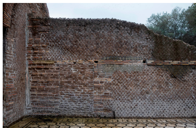
Figura 34. Muro de obliteración de la apertura central del frente monumental y muro transversal para la construcción de Hospitalia (fotografía autor).
