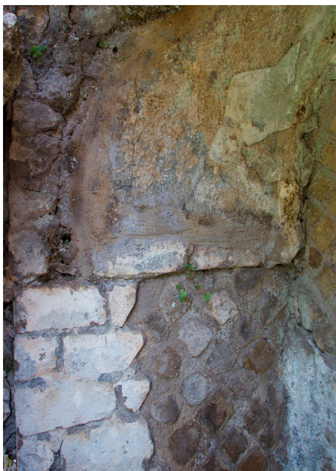
Figura 28. Detalle de la construcción de las hornacinas del cuerpo B (fotografía autor).
