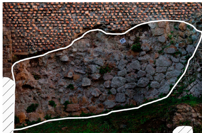
Figura 2. Sistema de aterrazamiento de la 1ª fase de la Villa Republicana en opus incertum (rodeado con línea), presente en el sector oeste de la terraza inferior Cortile delle Biblioteche (fotografía autor).
