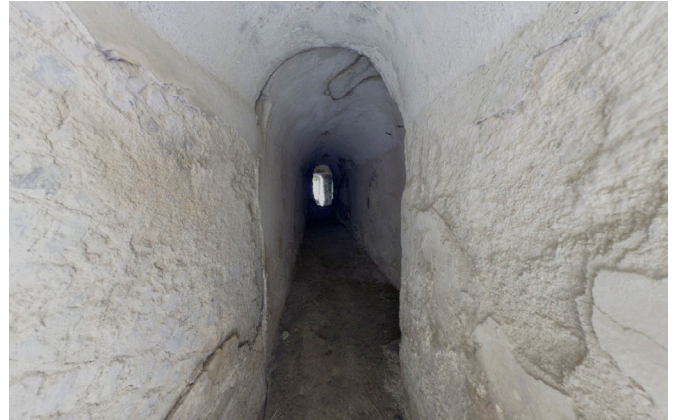
Figura 15. Corredor hipogeo del bloque constructivo B (fotografía autor).
