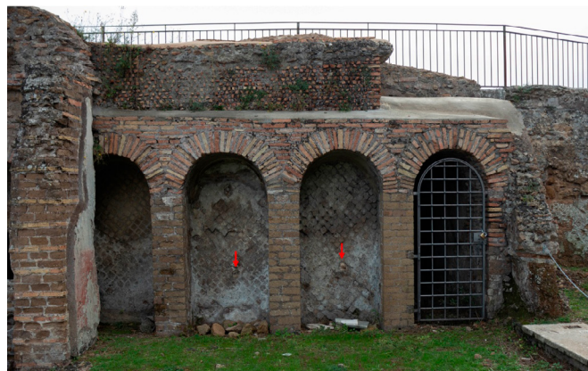
Figura 29. Sector oeste del bloque B; en rojo las aperturas llevadas a cabo en las hornacinas (fotografía autor).
