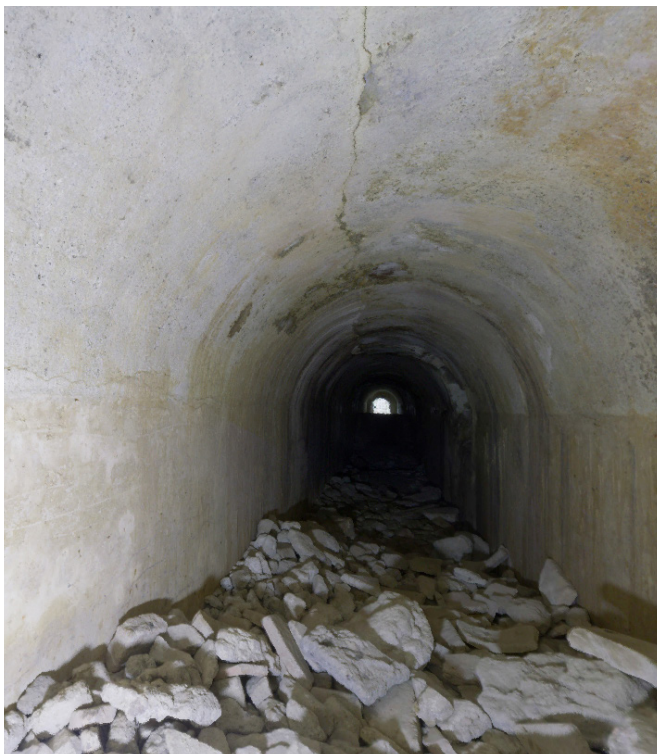
Figura 14. Corredor hipogeo del bloque constructivo A (Fotografía autor).
