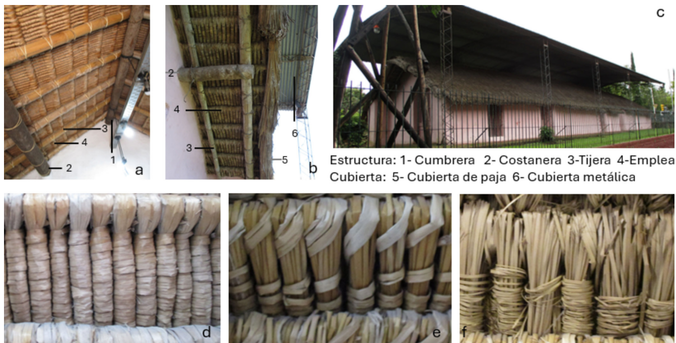
Figura 6a y b: Componentes de la estructura horizontal en interior y exterior. c: Exo-estructura metálica que protege a la cubierta primitiva. d, e y f: Detalle del motivo del cielorraso, diferencias en el entramado resultante entre la primera, tercera y quinta sala. Fotografías de la autora.
