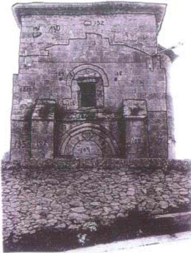
Fig. 5. Unidades Estratigráficas Murarias en la fachada de Poniente
