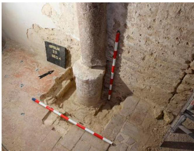
Figura 27. Iglesia de San Pedro de Sanlúcar la Mayor. Recalce de la columna del arco divisorio de los dos tramos del ábside. Nótese el desequilibrio forzado entre la base y el fuste. A pesar de la diferencia entre los dos pavimentos, el cimientó inferior es homogéneo, lo que demuestra que inicialmente hubo un único pavimento en los dos tramos. Autor: M. A. Tabales.
