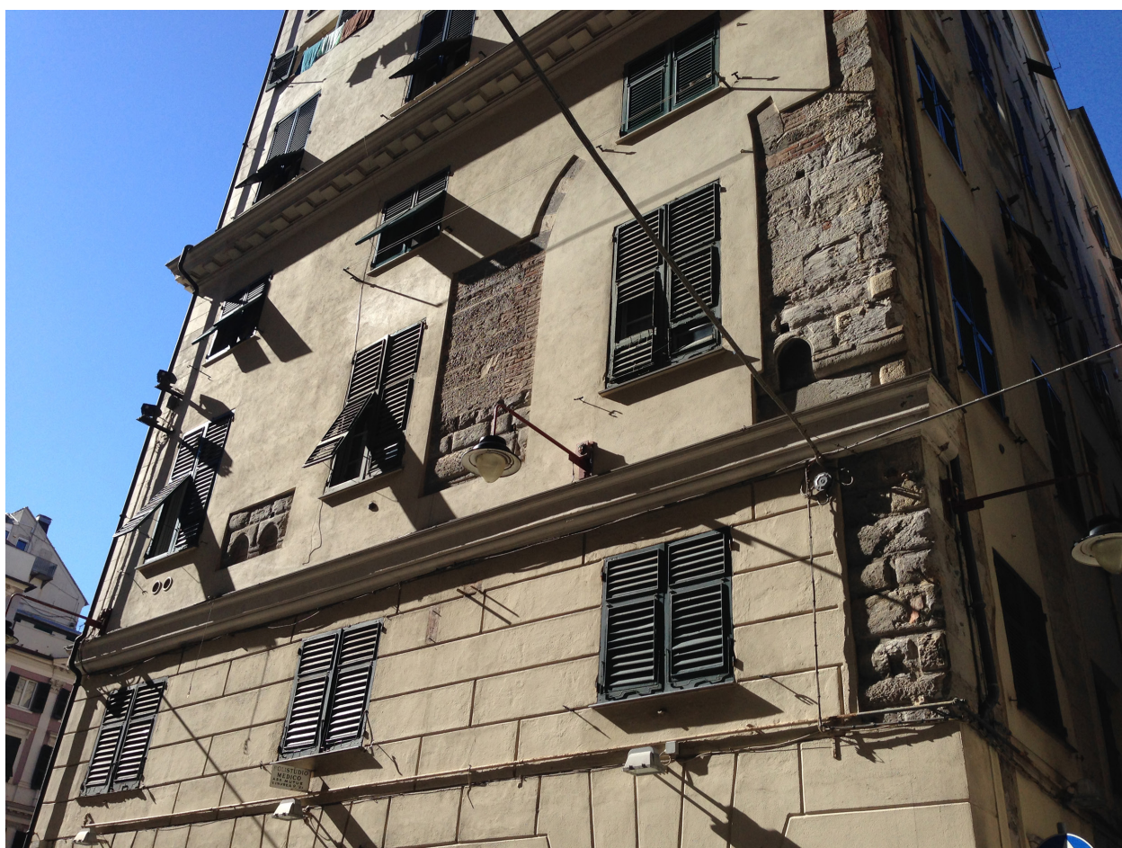
Figura 1. Genova, edificio in via di Scurreria. Esempio di edificio stratificato in cui il restauro ha seguito la logica del "palinsesto di strati": attraverso la rimozione selettiva di porzioni di intonaco si è perseguito l'equilibrio tra la perdita di materia e la valorizzazione delle due principali fasi storiche che vengono anche percepite come sovrapposte. Autore Lucina Napoleone.
