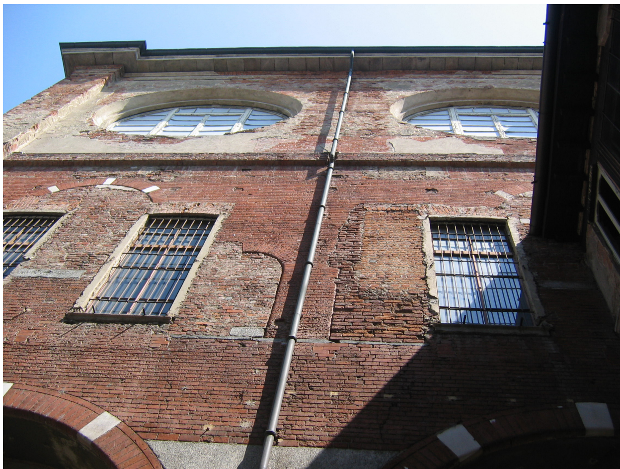
Figura 3. Milano, palazzo della Ragione. In questa immagine sono visibili innumerevoli punti di discontinuità, intenzionali o dovute a processi di degrado che compongono il "palinsesto di tracce". L'intervento ha avuto come obiettivo la Conservazione integrale delle tracce senza demolizioni o integrazioni, facendo coincidere, concettualmente e di fatto, il "palinsesto" precedente e quello successivo all'intervento. Autore Lucina Napoleone.
