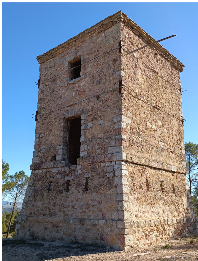
Figura 21. Torre n.º 21 de la Altura de la Paradilla.
