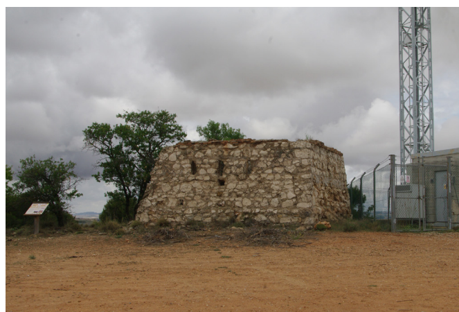
Figura 10. Torre n.º 9 de Belinchón, Belinchón.
