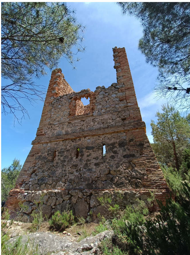
Figura 24. Torre n.º 26 del Alto de la Portilla, Buñol.
