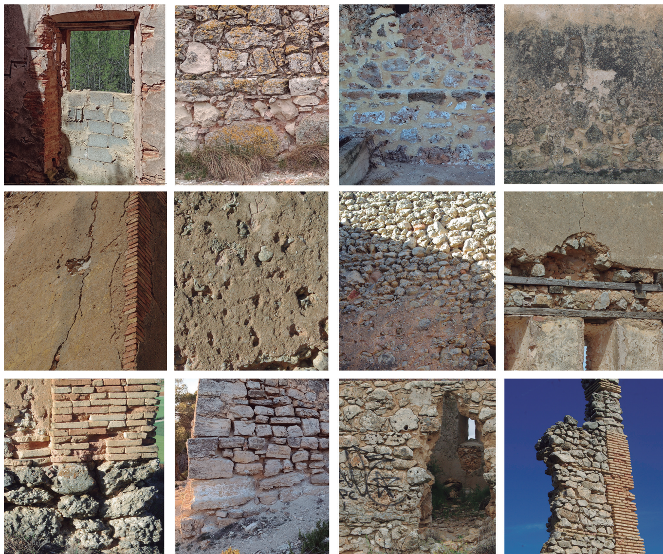
Figura 33. Ábaco de las degradaciones frecuentes en la red sistémicas.
