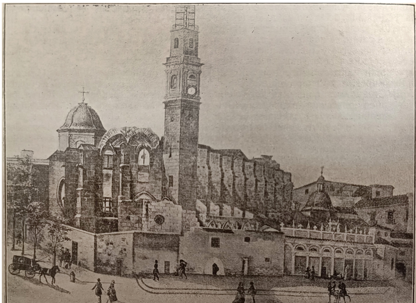
Figura 28. Imagen histórica del aparato telegráfico sobre el campanario del Convento de San Francisco, Valencia.
