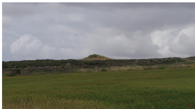
Figura 13. Restos de la torre n.º 13 de Montalvo, Montalbo.
