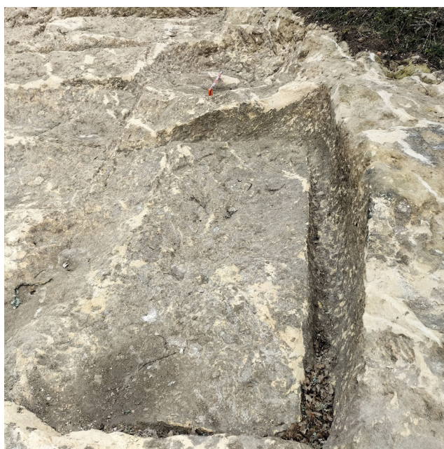
Figura 5. Escotaduras y superficie de arranque basal muy irregular. Todo ello trabajado con puntero.
