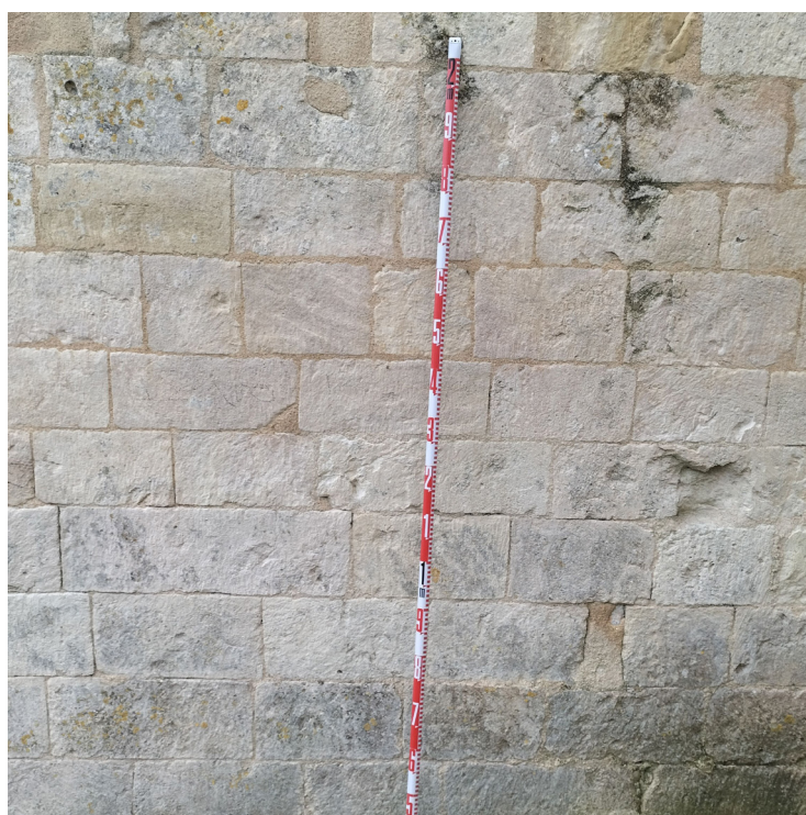
Figura 2. Pared occidental de sillería ex novo de dolomía de la fase prerrománica II (ca. 939).
