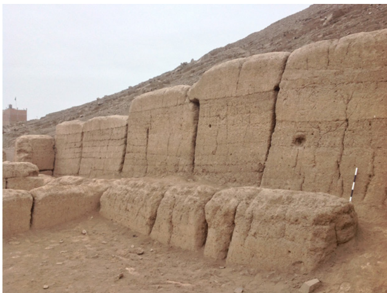
Figura 11. Muro con segmentaciones verticales, ubicado en la Huaca Palacio de Oquendo, en Lima, Perú. Elaboración propia.
