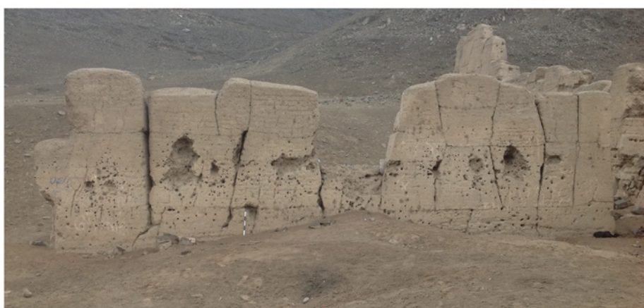
Figura 12. Análisis estratigráfico de las fases constructivas del muro arqueológico, se muestran los 3 grandes momentos constructivos. Las flechas señalan la ubicación de los muros que actúan como claves.
