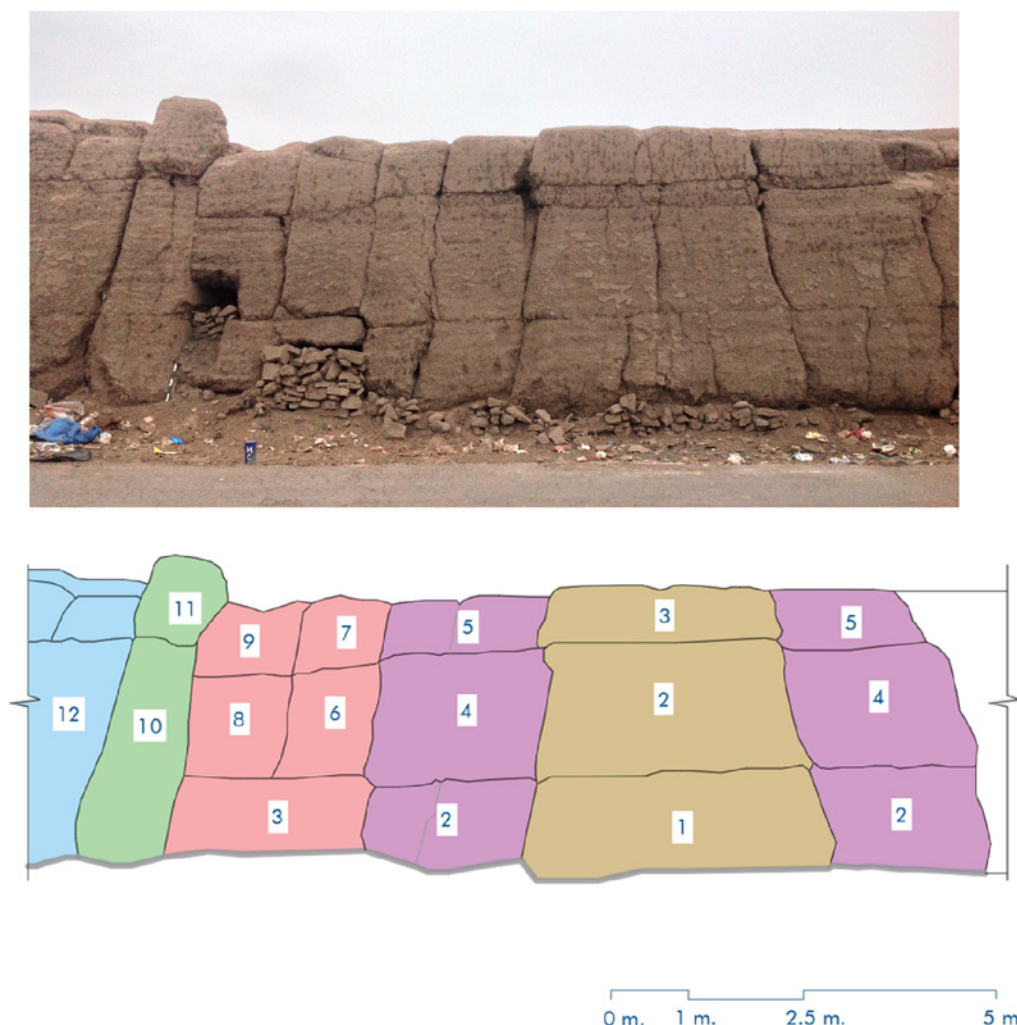
Figura 14. Análisis estratigráfico de las fases constructivas de un segmento de la muralla de Chuquitanta, se muestra la secuencia de cinco momentos constructivos. Los muros se van adosando unos a otros a partir del muro ordenador. Fuente: Torres (2021).
