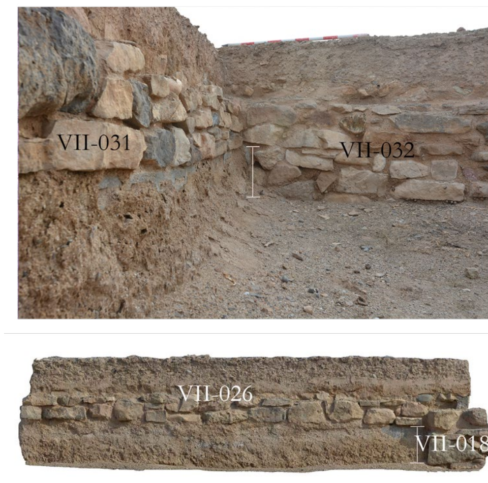
Figura 9. Diferencia de cota en el arranque de dos muros colindantes en el sector VII. Elaboración propia.
