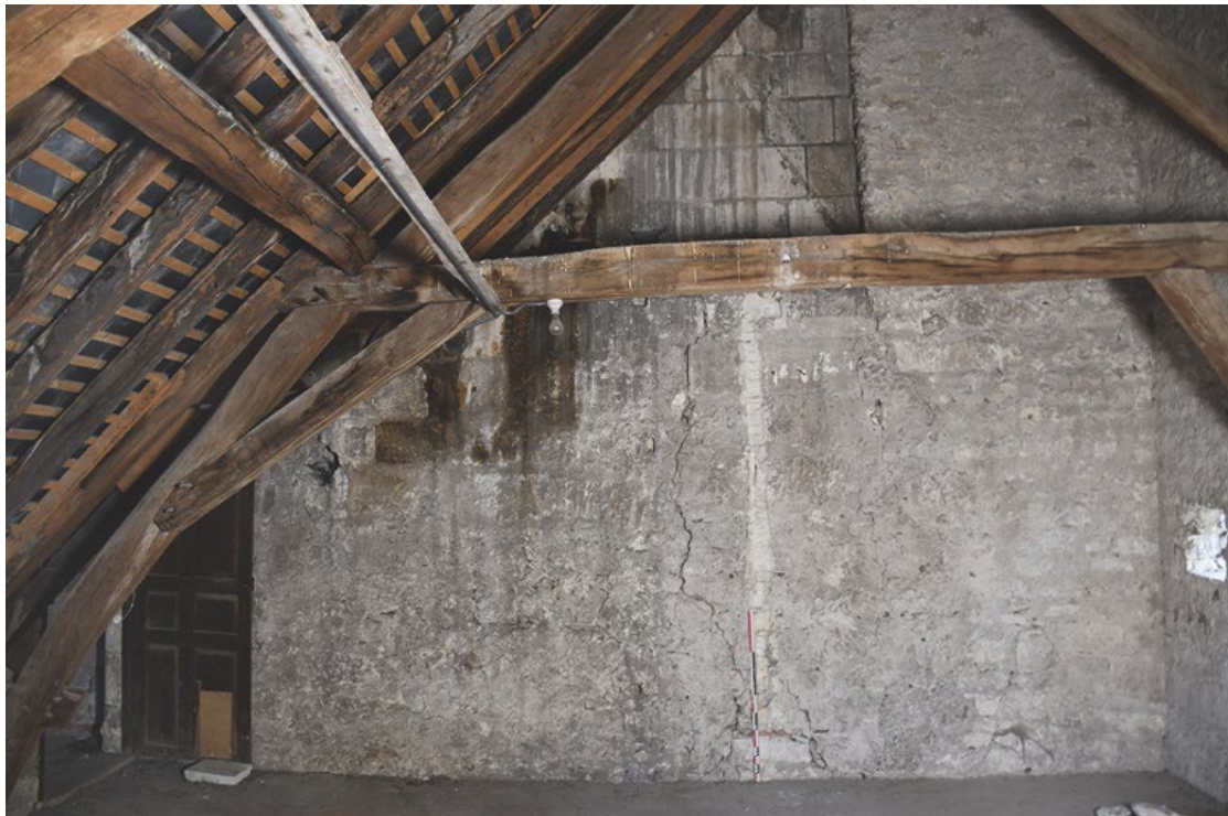
Figure 14. Vue de la Pièce 3 vers l'est. Photo : Piero Gilento, Inrap.
