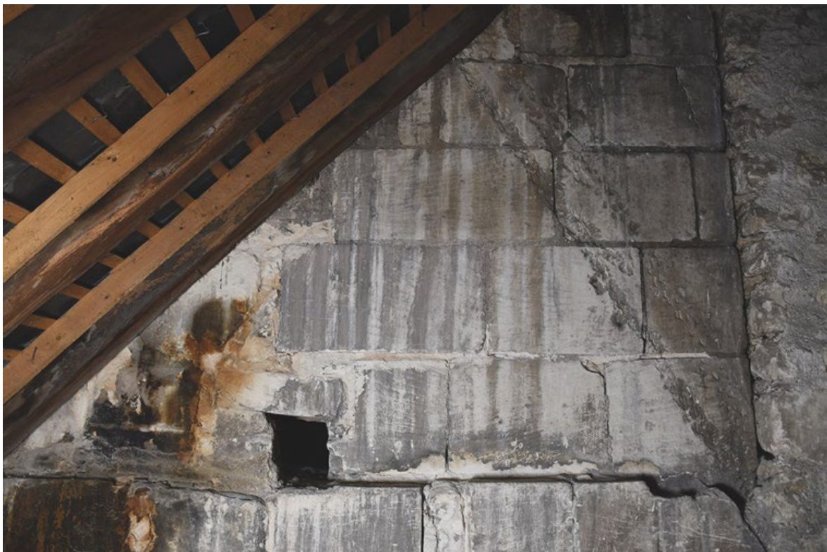
Figure 25. Détail de la partie supérieure du mur 3 dans la Pièce 3, caractérisé par la présence des traces de solins d'une probable charpente antérieure au début du XVI e siècle (F123).
