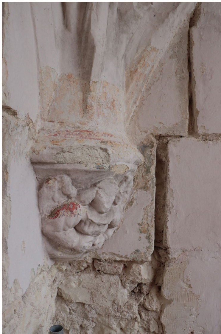
Figure 34. Détail du culot de retombée de la voute orné d'un ange. Photo : Nicolas Holzem, Inrap.
