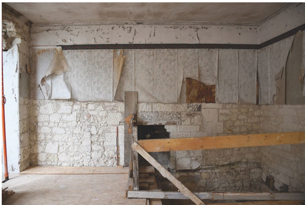
Figure 12. Vue de la Pièce 2 vers l'est. Photo: Piero Gilento, Inrap.
