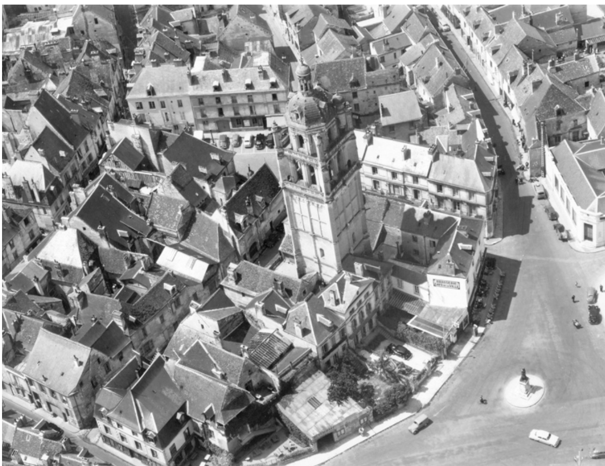
Figure 19. Loches, vue aérienne de la tour Saint-Antoine, photographie Roger Henrard, après 1950 (ADIL 17 Fi 0081).
