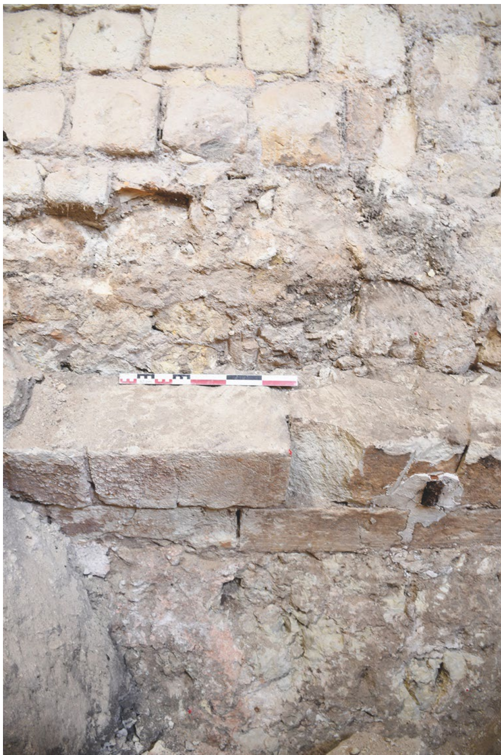
Figure 9. Vue des traces de l'ancienne voute de la cave.
