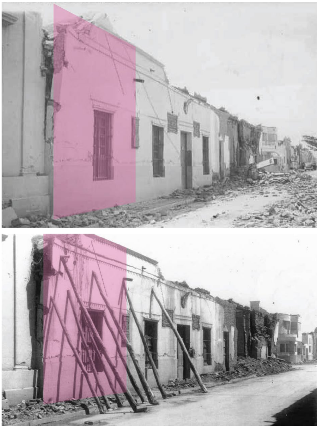
Figura 7. Dos fotografías de la casa tomadas pocos días después del terremoto, en color sombreado se destaca la sección que corresponde a la vivienda original (arriba: AGN 1944a; abajo: ACNS 1944).
