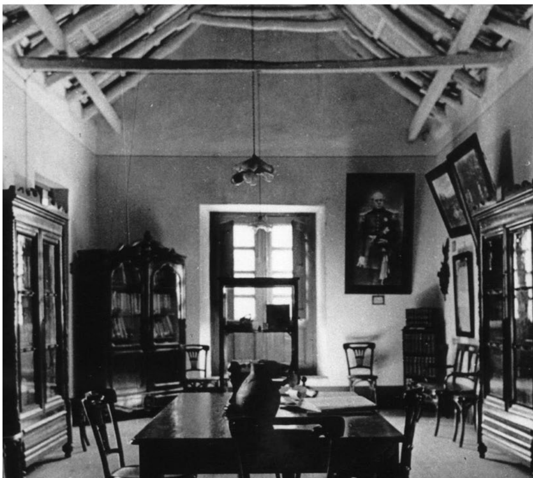
Figura 6. Arriba: Fotografía de marzo de 1918 de la Sala Natal donde se pueden ver las paredes empapeladas y un cielorraso decorado (ACNS 1918). Abajo: Vista de la misma habitación cerca de dos décadas después, con la estructura del techo expuesta por el retiro del cielorraso (ACNS 1939). Fuente: fotografías del ACNS.
