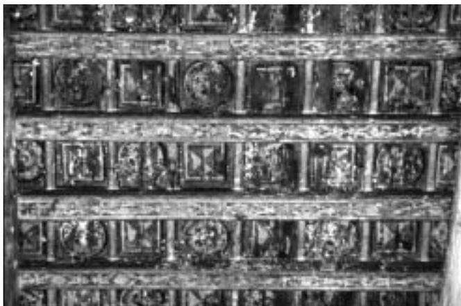
Fig.6. Solaio ligneo con intradosso decorato (via delle Compere 2 - Genova). Lo studio degli incastri e delle modalità di decorazione chiarisce quali lavorazioni siano state eseguite in opera
