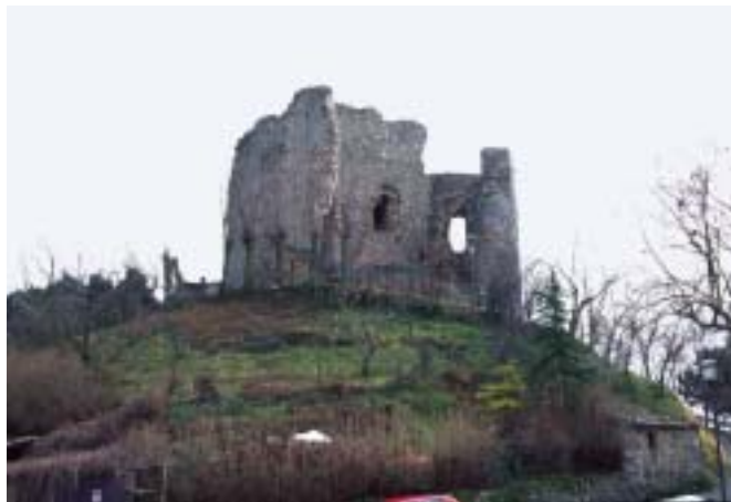
Fig. 2: La rocca di Montelaterone vista da nord est
