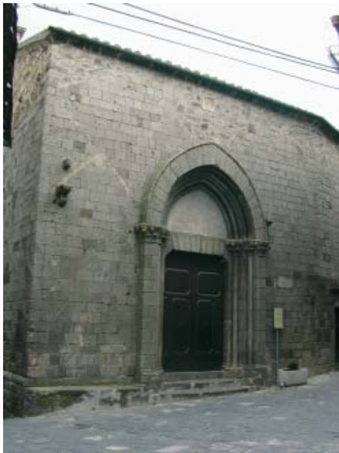
Fig. 5. Facciata della chiesa di San Clemente nel borgo di Montelaterone. In questo complesso architettonico, databile al tardo XIII secolo*, le murature sono realizzate in trachite/peperino
