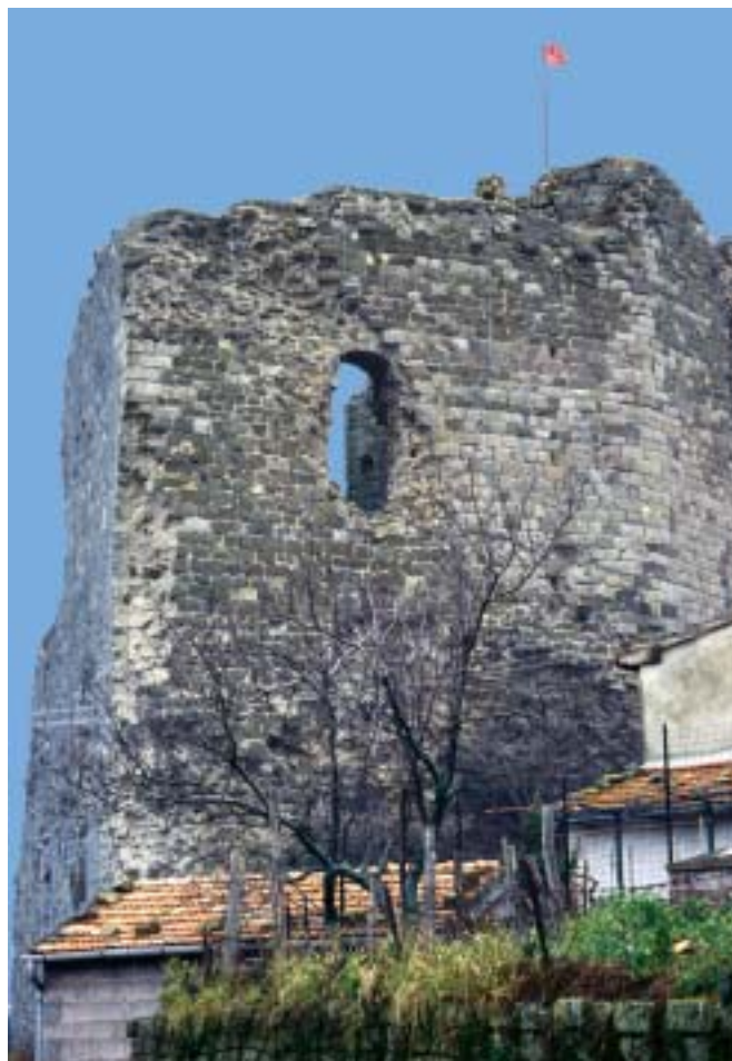
Fig. 4. Dettaglio del prospetto sud orientale (D) della rocca in cui si riconosce (sulla sinistra) l'imitazione in arenaria del tipo 1 in trachite/peperino (a destra dell'apertura)
