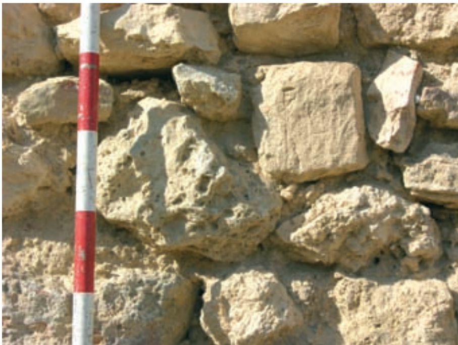
Fase 6. Areniscas en las que se puede observar la talla
