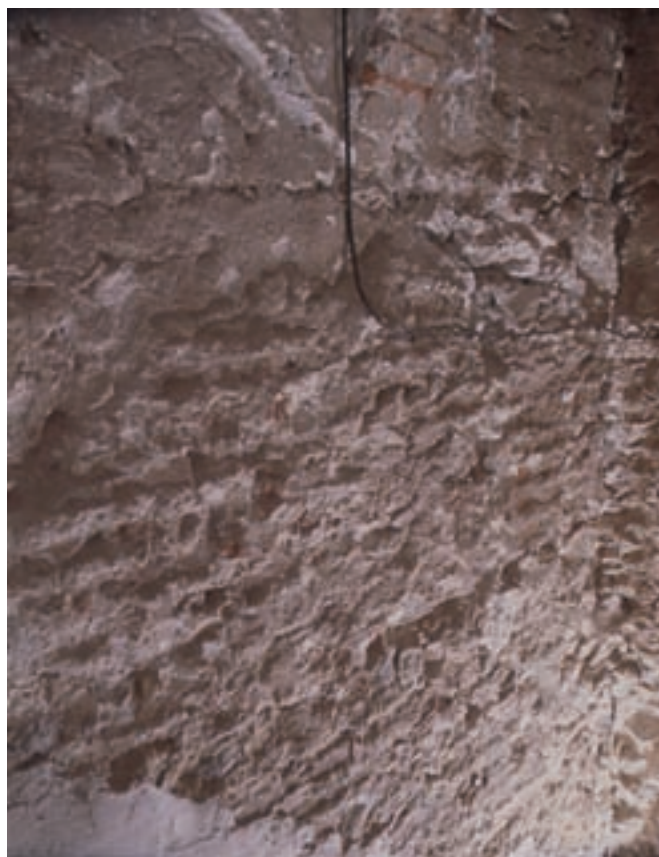
Fig. 5. San Pedro El Viejo, Huellas del desmonte de los adobes en la fábrica de calicanto
