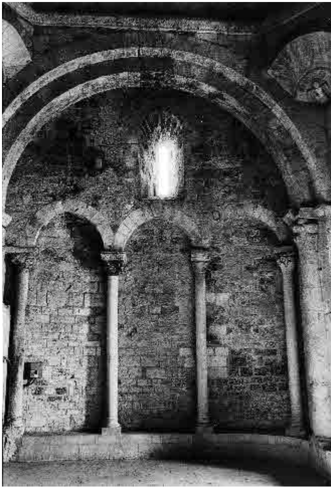
Fig. 7. Viviers, clocher, intérieur de la chapelle d'étage (cl. Y. Esquieu)
