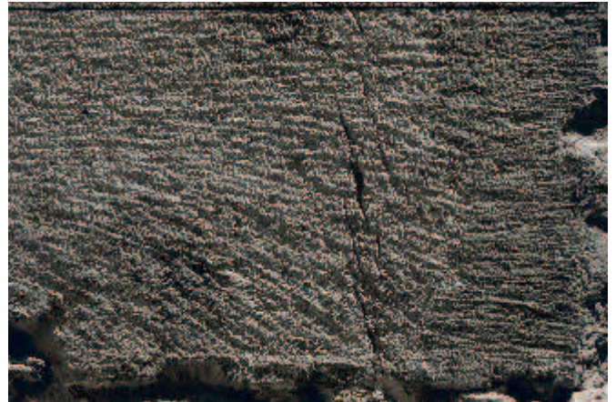
Figure 22. Bloc de l'embrasure est : impacts de marteau taillant et ciselure périmétrale (cliché A. Hartmann-Virnich, 2002)
