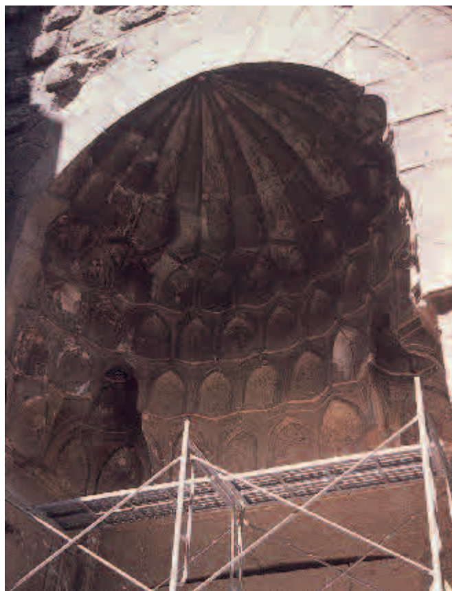
Figure 17. Vue de la porte orientale avant restauration (cliché A. Hartmann-Virnich, 2002)
