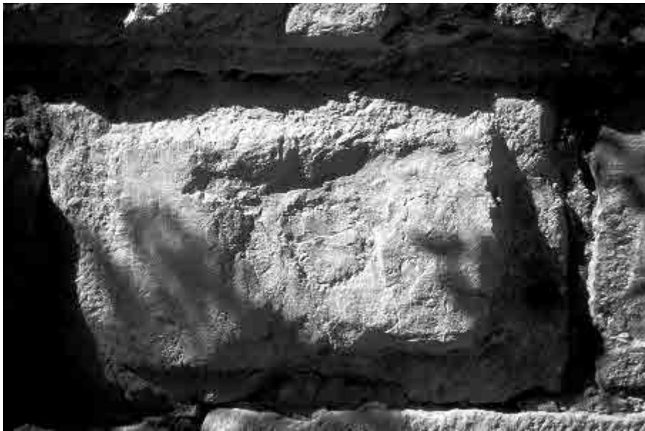
Fig. 6. Marque lapidaire médiévale islamique ronde sur un bossage d'économie brut de débitage. Façade orientale de la tour 7 (ph. J.-C. Bessac, CNRS)
