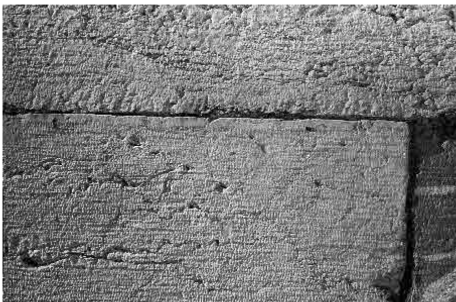
Fig. 4. Taille standard ciselée grain d'orge perpendiculaire aux arêtes des blocs. Angle nord-ouest de la façade septentrionale du bâtiment sud-ouest («palais») au rez-de-chaussée (ph. J.-C. Bessac, CNRS)
