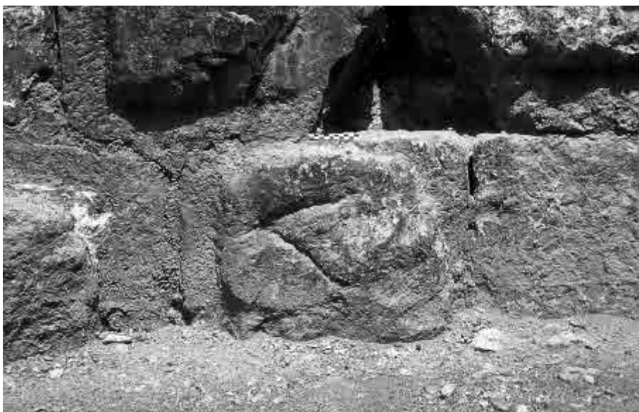
Fig. 7. Bossage d'économie marqué d'une ligne brisée. Façade orientale de la courtine initiale, au sud du «palais», à l'emplacement d'une reprise (ph. J.-C. Bessac, CNRS)
