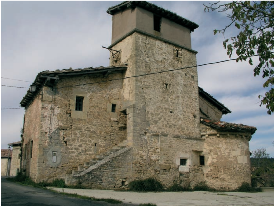
Fig. 1. Aspecto general de la iglesia desde el SE.
