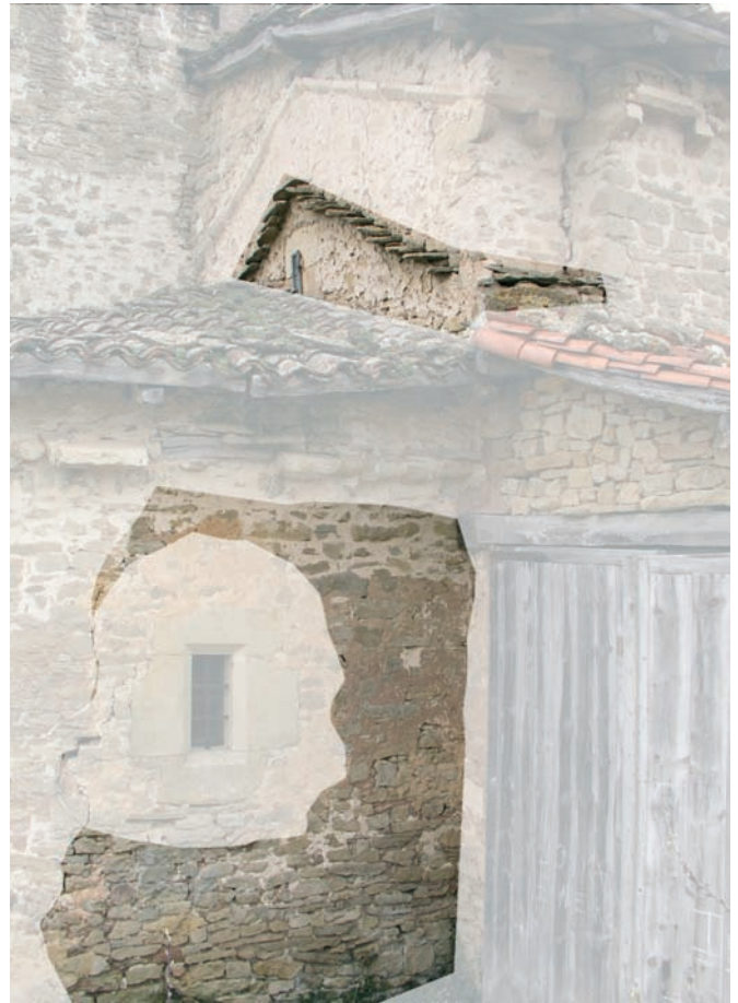
Fig. 7. Aspecto de los elementos de la fase 1 en la cabecera de la iglesia
