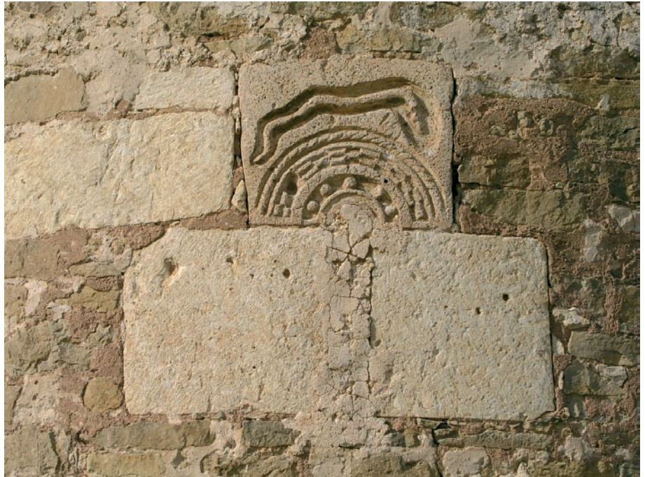
Fig. 2. Ventana de la cabecera de la iglesia.
