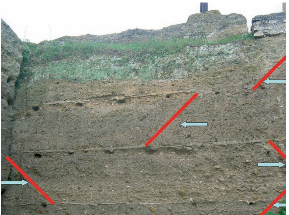
Fig. 10. Juntas oblicuas en los cajones de tapial del lienzo situado al otro lado de la carretera (recinto del Parque)
