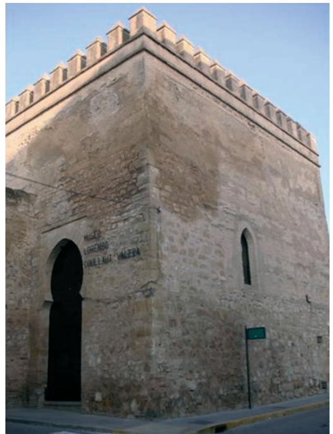
Fig. 16. Imagen actual de los alzados norte y oeste de la Puerta de Morón
