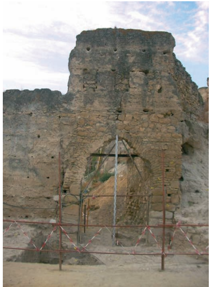
Fig. 11. El Portillo. Imagen durante el transcurso de las excavaciones
