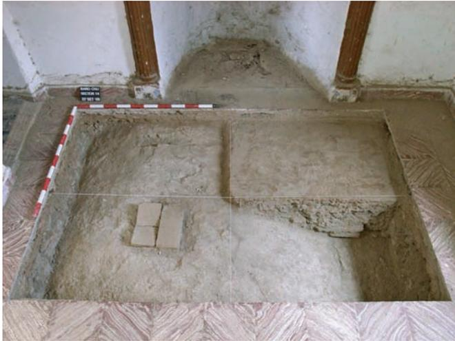
Fig. 5. Vista del extradós de la bóveda de la sala caliente en curso de excavación (sondeo 14, véase su situación en la sección de la Fig. 6). A la izquierda, dos ladrillos ciegan una lucerna con objeto de posibilitar la colmatación de la bóveda
