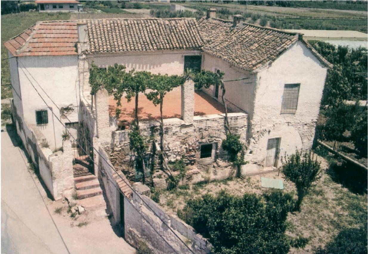
Fig. 1. Vista del edificio del baño de Churriana de la Vega a principios de 1996, última fecha de ocupación de la vivienda. Las bóvedas visibles en la fachada se corresponden, de izquierda a derecha, con las salas fría, templada y caliente del baño
