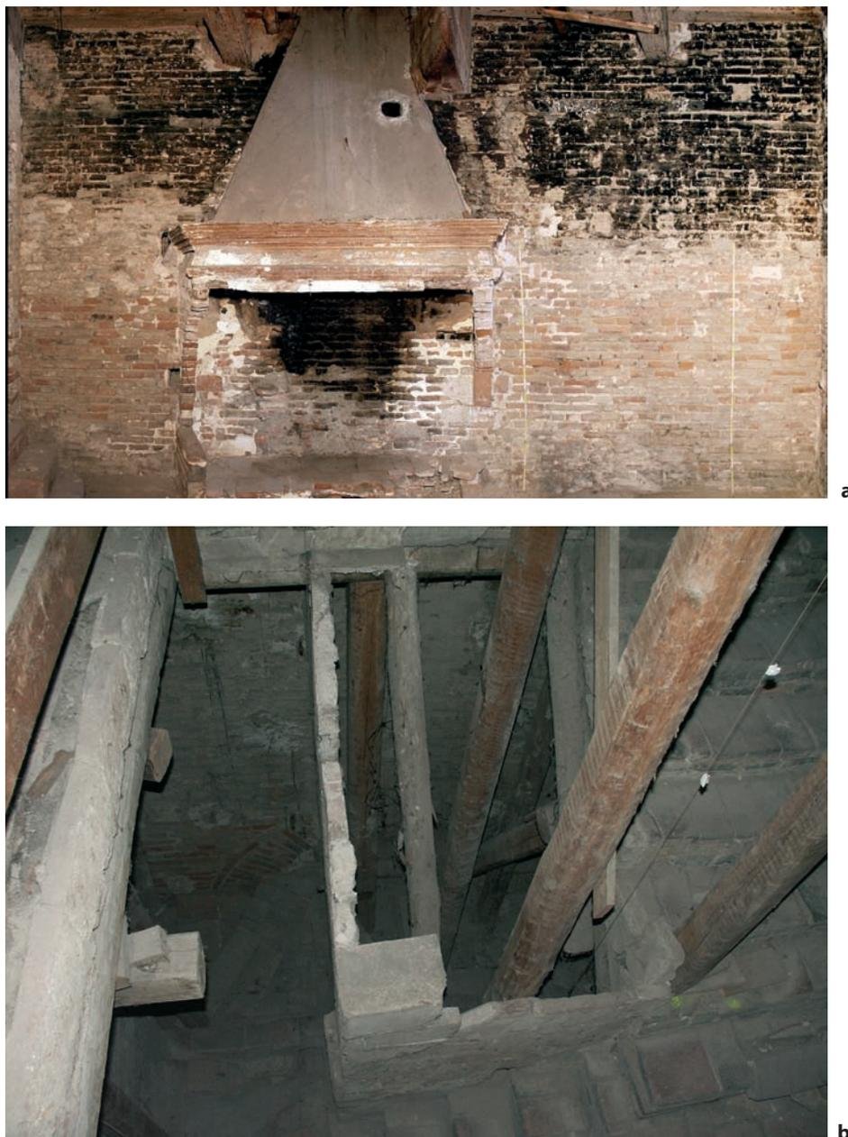
Fig. 12 A-B. Primo piano: un camino ed il corpo scala addossati alla muratura iniziale e all'arco d'ingresso
