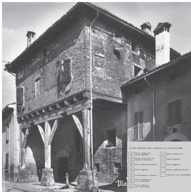
Fig. 6 A-B- Dalla comparazione fra risultati delle osservazioni sulla fotografia storica ed esisti della lettura diretta delle superfici sono emersi gli indizi di un innalzamento dell'edificio e di un processo di smontaggio e rimontaggio degli elementi lignei di facciata
