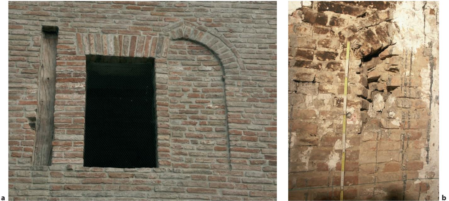
Fig. 7 A-B. Un diverso grado di leggibilità distingue le aperture restaurate da quelle non manipolate, le prime distinguibili solo per forma, le seconde leggibili stratigraficamente
