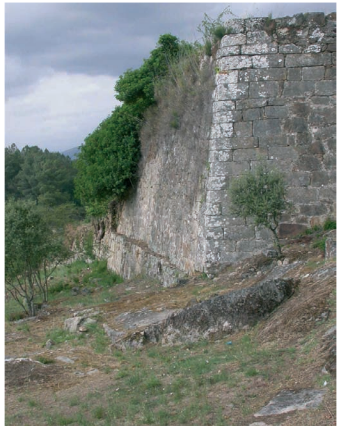
Fig. 10. Baluarte de la fortificación moderna del Castillo de Monterrei. Se puede apreciar que en la cimentación se emplea el mismo sistema de banquetta documentado en el Baluarte de Elle
