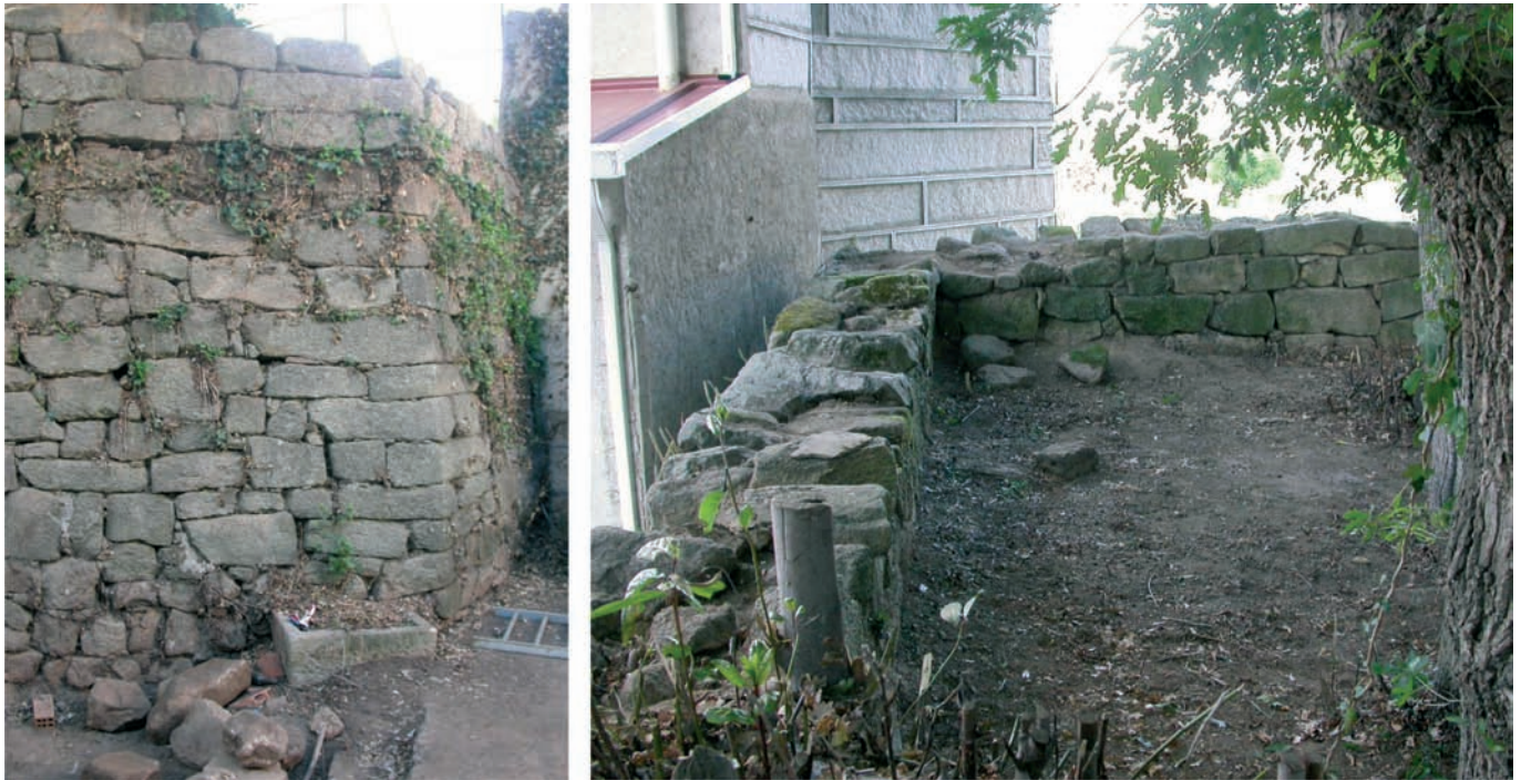
Fig. 9. Distintos aspectos del baluarte de la Calle de Elle. En la imagen de la izquierda la unión entre la cara y el flanco, en la imagen de la derecha la parte superior del ángulo capital
