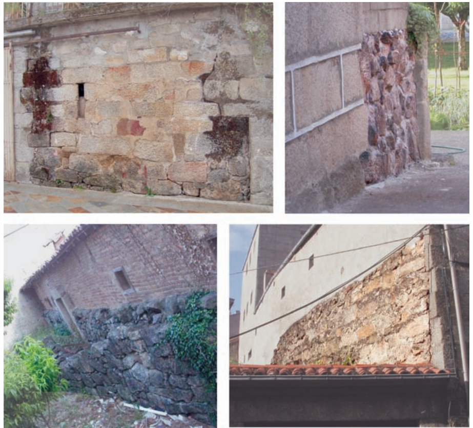
Fig. 13. Estructuras identificadas durante la prospección del casco urbano de Verín. En la imagen superior izquierda el muro con saetera ES050530U04; en la inferior derecha el muro en talud ES050615U01; las otras dos imágenes se corresponden con muros localizados en la Calle Muralla
