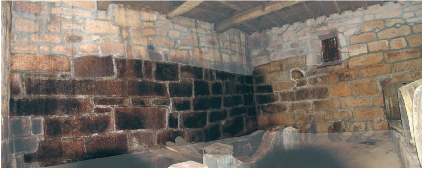
Fig. 7. Restos del torreón bajomedieval identificados en el sector 7
